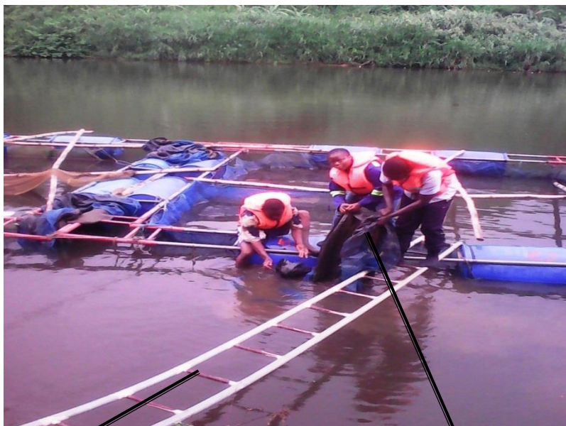
Photo 3 : a) Paserelle après réajustement
