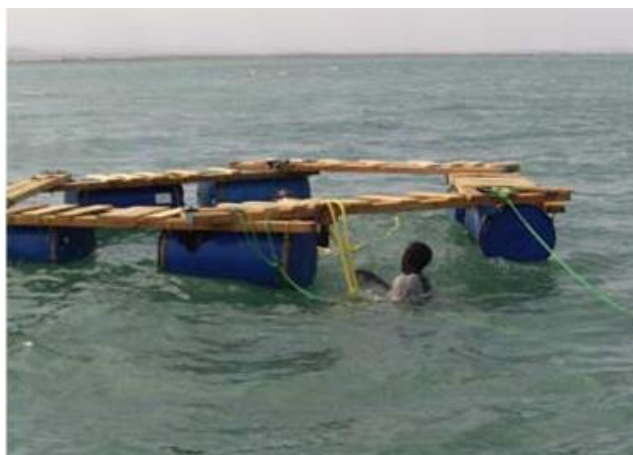
Figure 21 : Points d'attache des aussières d'amarrage à la cage.
