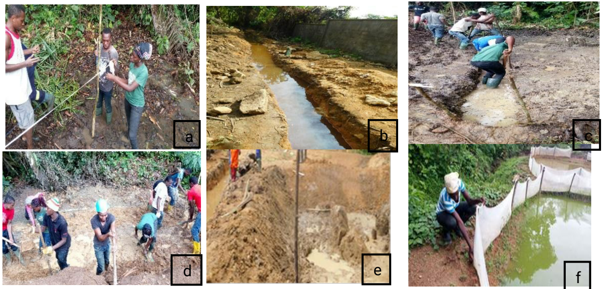
Figure 5: construction d'un étang (a), canal d'alimentation (b), Creusage du noyau d'étanchéité (c), formation de l'assiette et des digues d), formation du talus de la digue(e), installation de l'enclos(f).
